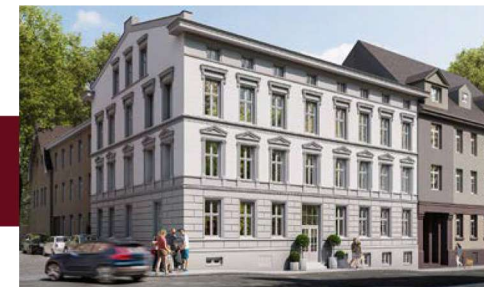
Widok budynku od strony ulicy
