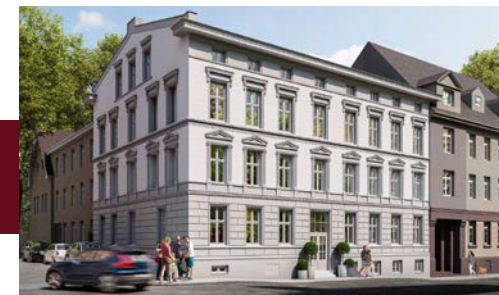
Widok budynku od strony ulicy
